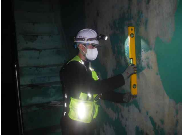
(배수지 내부 : 기울기측정 전경)
