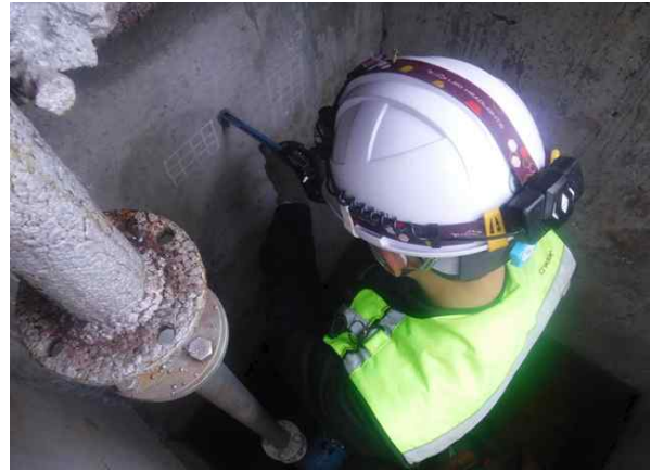
(콘크리트 탄산화 깊이 측정)
