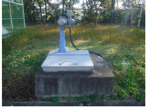
〔2호지 유입밸브실 : 점검구덮개 상태양호〕
