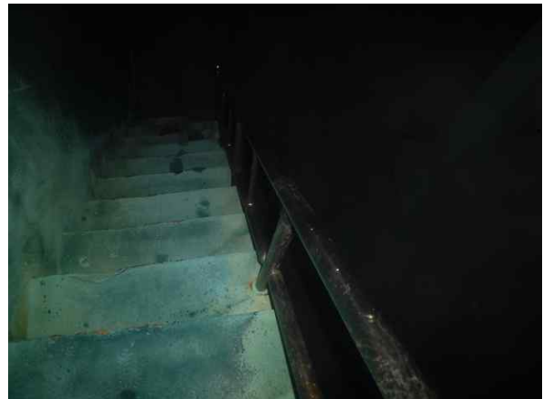
〔배수지 2호지 : 사다리 상태양호〕
