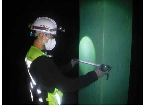
(배수지 내부 : 부재규격조사)
